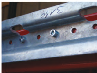
Figuur 11: Balk met bevestigingspunten
